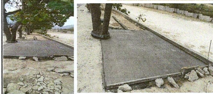
Foto 2: Preparación del lugar donde se estará mejorando la losa de patio del centro educativo para tener un ambiente agradable y podrá utilizarse para las diferentes actividades educativas.
