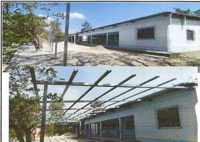
Foto1: Área donde se está instalando la estructura de techo de lámina, espacio que será utilizado para poder realizar reuniones con padres de familia y realizar diferentes actividades educativas
